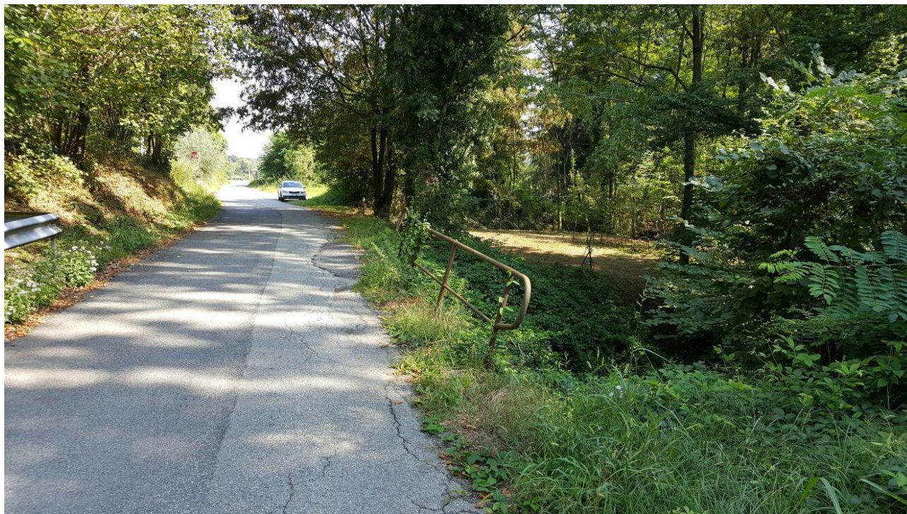
Figura 1- Intervento A - Immagine stato di fatto
